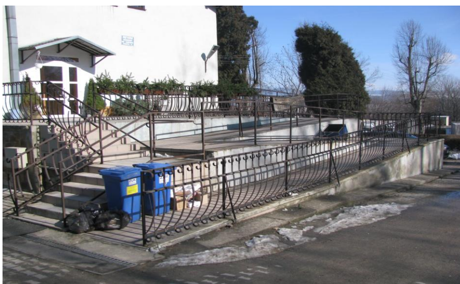
wejście do budynku z pojazdem dla niepełnosprawnych
