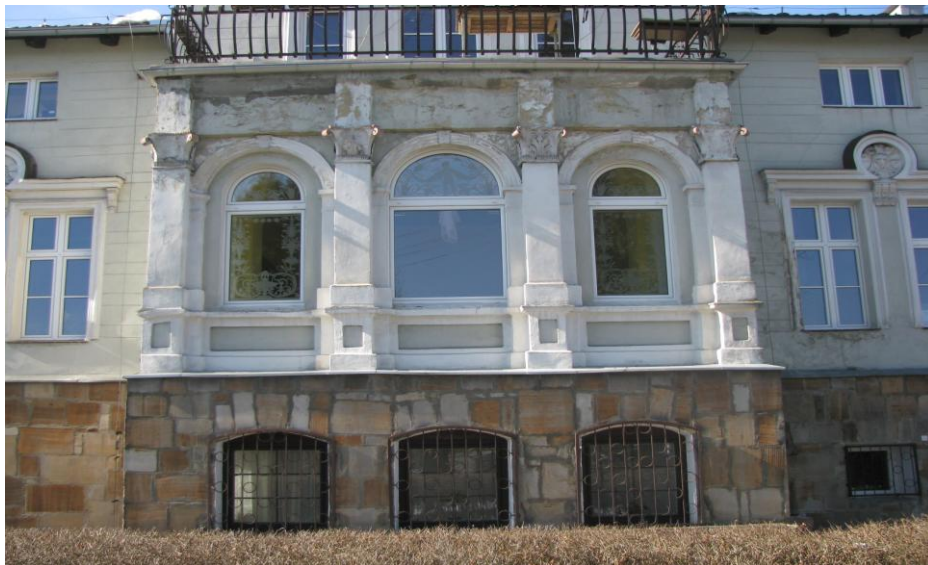
detale elewacji – front wykuszu
