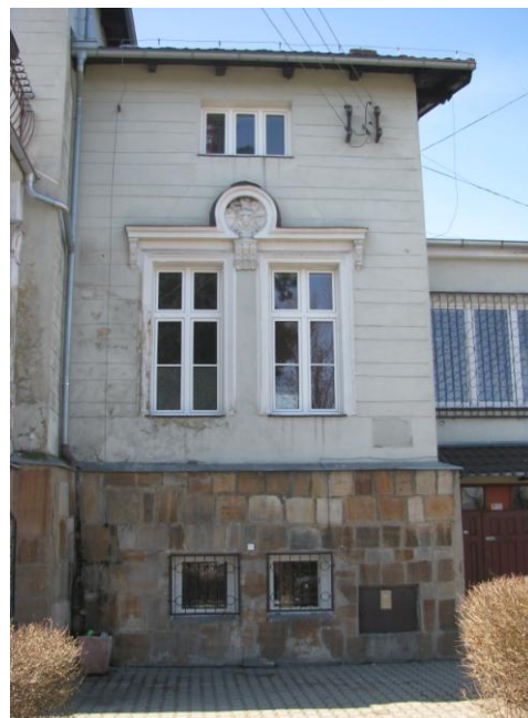
fragment ściany frontowej – prawy
