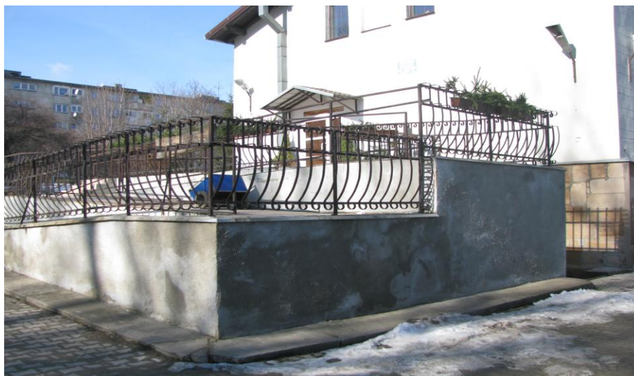
tynki zewnętrzne wejścia do budynku
