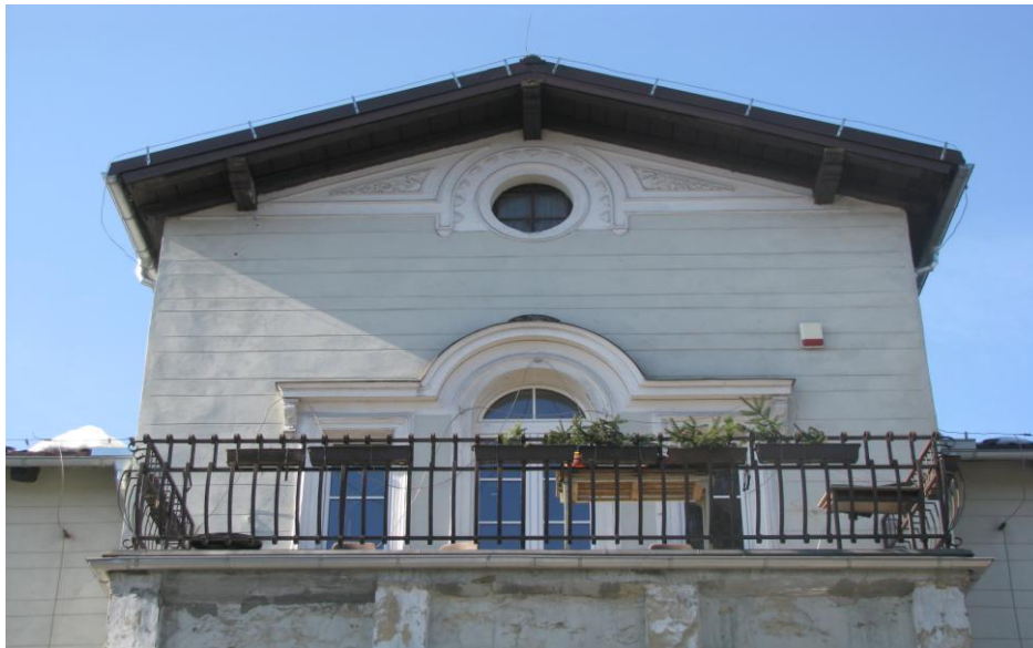
detale elewacji – fragment nad tarasem
